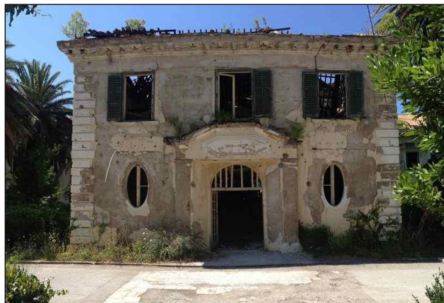
Dnešní stav vstupního průčelí původního Grandhotelu je žalostný
