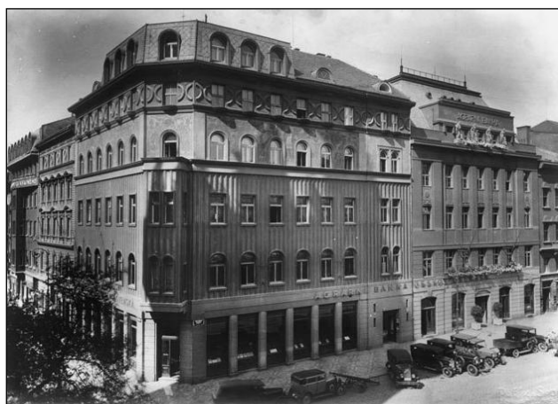
Palác Agrární banky v Jindřišské ulici, kde byly kanceláře firmy
