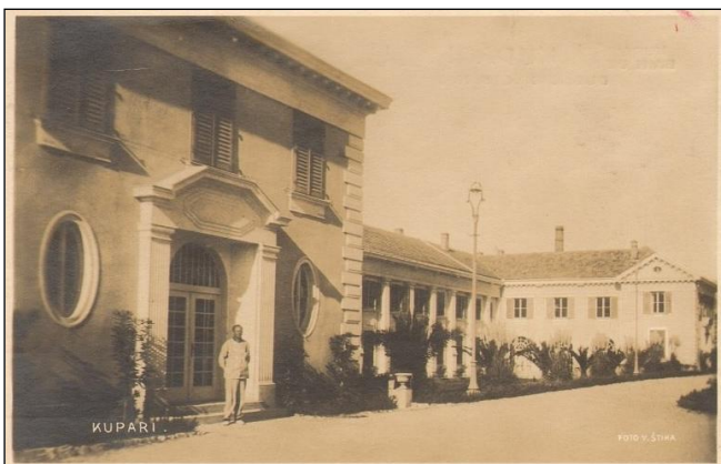
Grand hotel byla druhou, nyní hlavní budovou. Hlavní vchod, 1926
