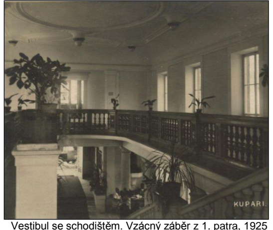
Vestibul se schodištěm. Vzácny záběr z 1. patra, 1925
